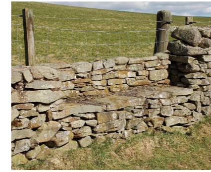
Zitelement in de muur
